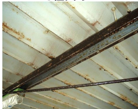
触指乾燥後、各所錆止め確認
